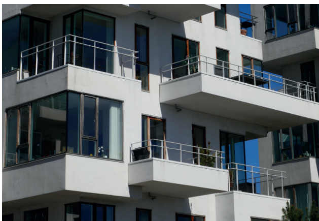
Garde-corps avec partie basse opaque Immeuble de logements - Copenhague
