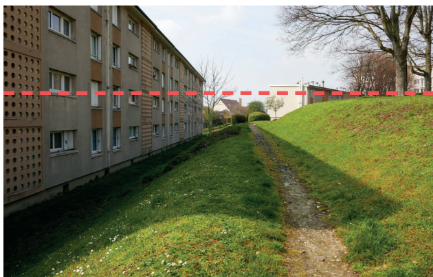
Situation actuelle en talus
